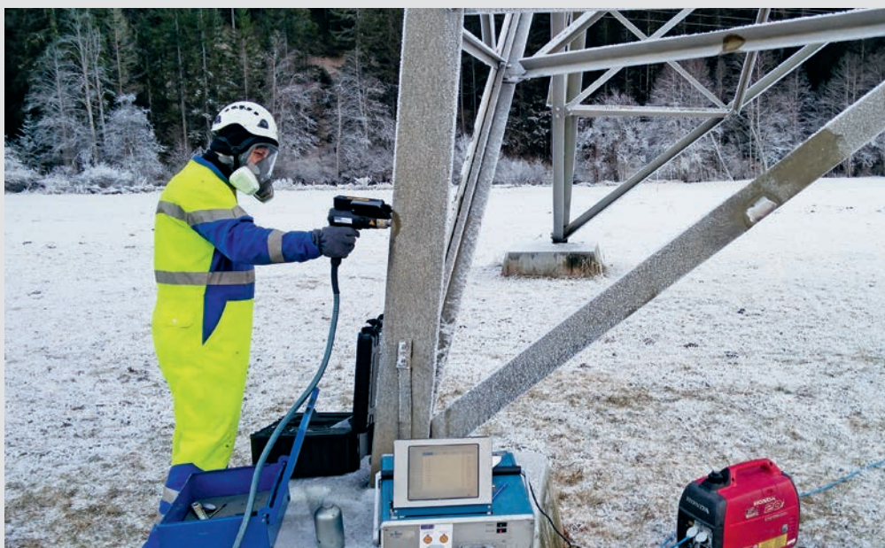
Mobile Untersuchungen (Abklärung Alterungsversprödung) an Hochspannungsmasten
