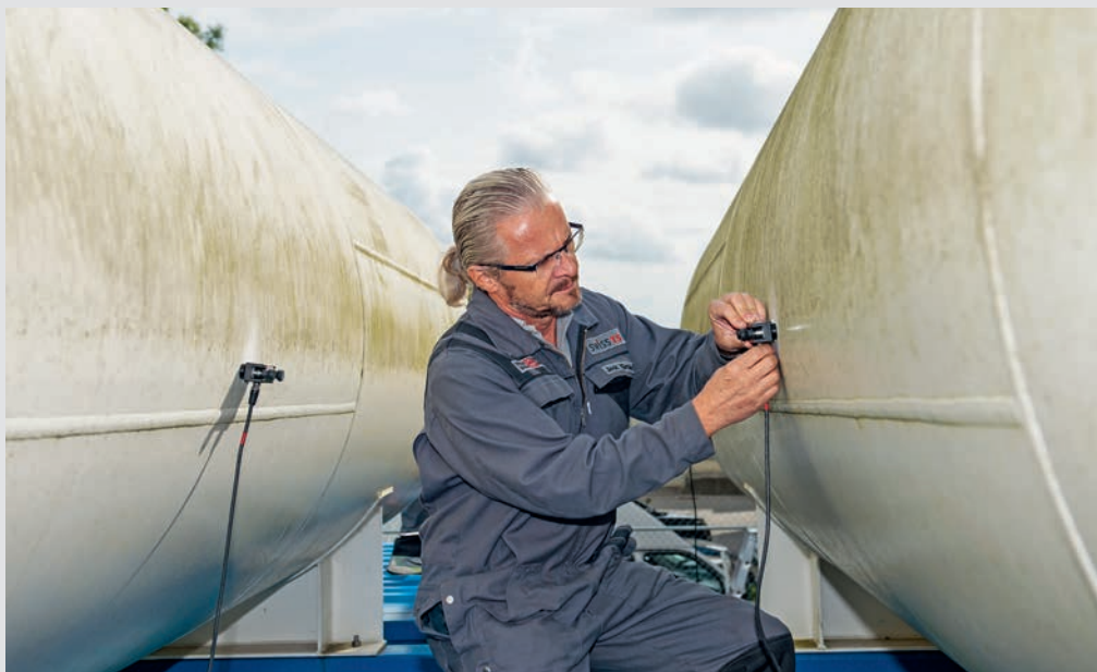
Anbringung von Schallemissionssensoren
